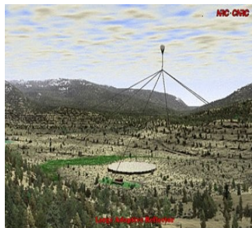
a) Telescópio suspenso por balão posicionado por 6 cabos sobre a superfície refletora (National Research Council of Canada)
